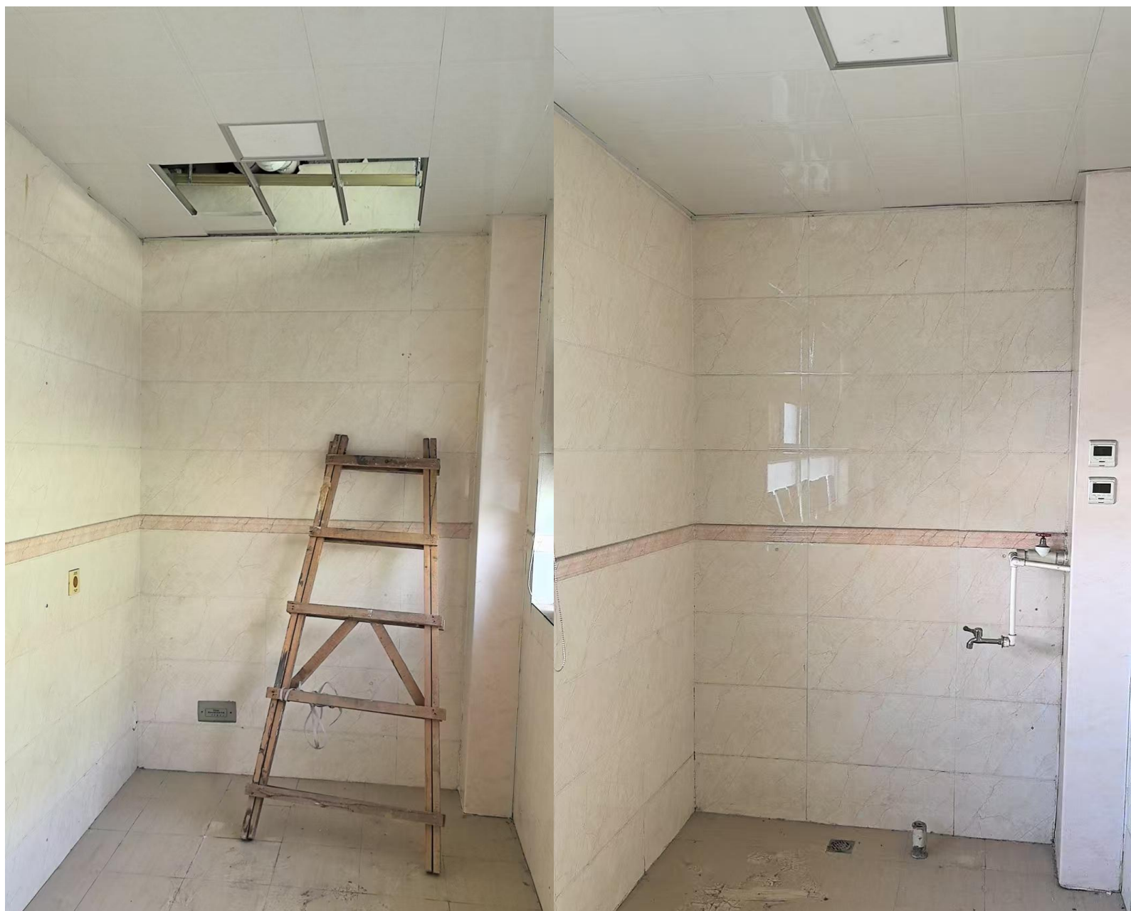
公厕北室内增加洗漱池（300*50*80,1.2厚201不锈钢，带5个水龙头），上、下水管道连接，修复吊顶
